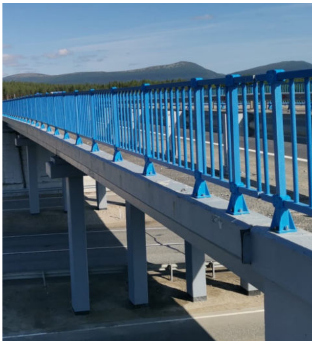
ПУТЕПРОВОД НА КМ 1154 А.Д Р-21 МУРМАНСКАЯ ОБЛ. Полнокомпозитное перильное ограждение для мостовых сооружений
