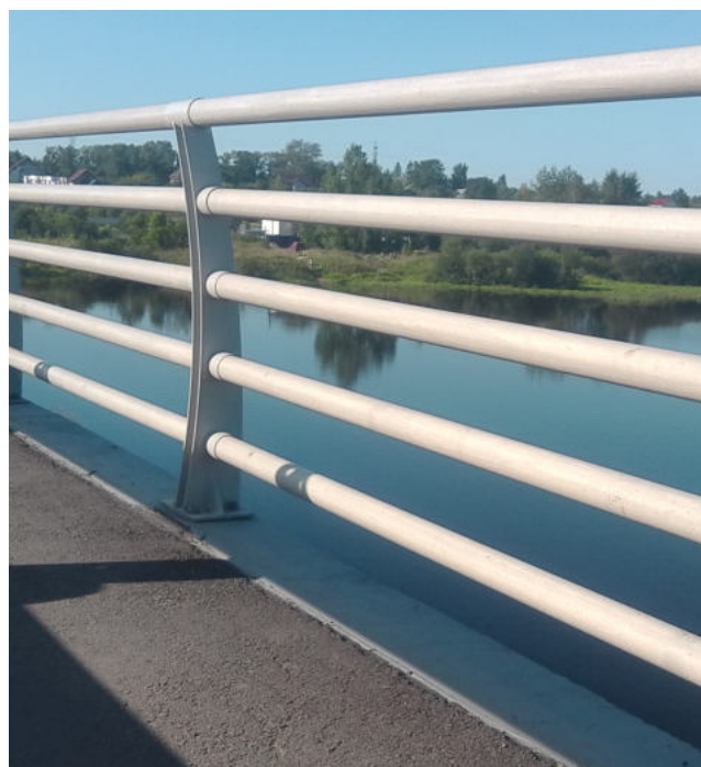
Г. ЧЕРЕПОВЕЦ. СЕВЕРНЫЙ МОСТ. Металлокомпозитное перильное ограждение
